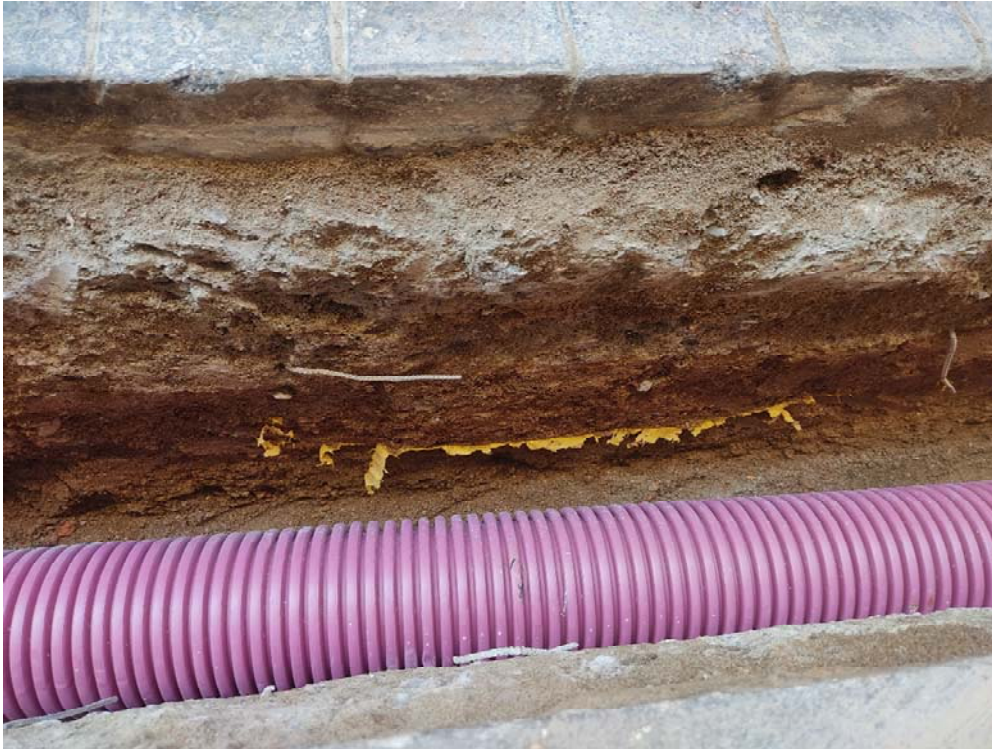
Foto 20: Perfil de la rasa del carrer de Lancaster 7. Nivell superficial UE1 i anivellament de sauló UE 2.
