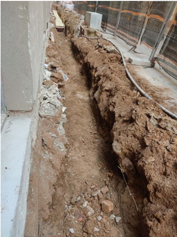
Foto 8: Vista general de la rasa finalitzada al carrer de l'Arc del teatre.
