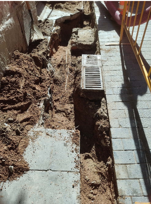
Foto 23: Desviament de la rasa del carrer de Lancaster 7-15 per salvar un embornal.
