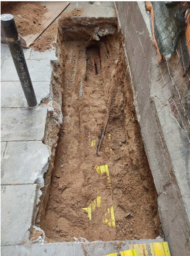
Foto 16: Finalització de la rasa fora del límit de l'obra a la placeta d'Anna Murià 1-2 amb carrer Lancaster.
