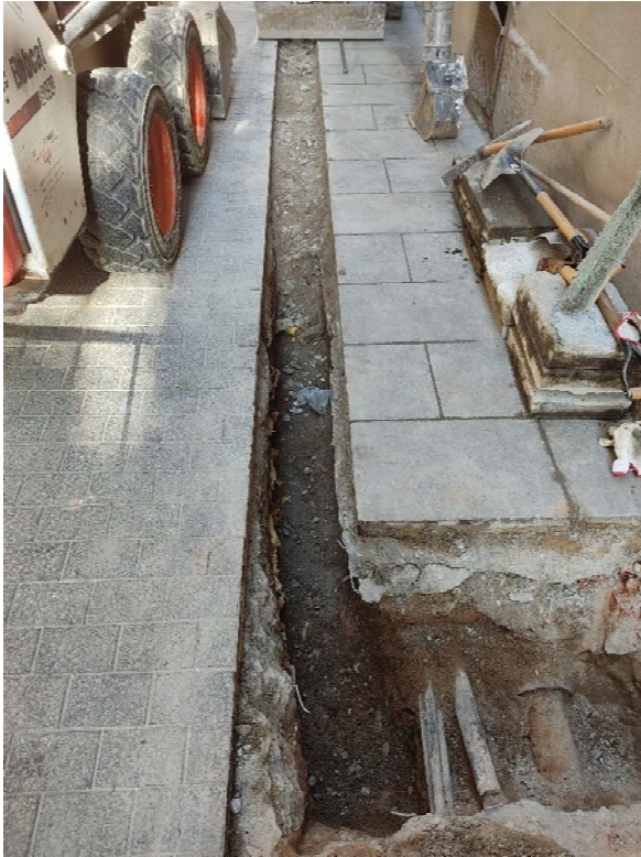
Foto 18: Inici dels treballs a la rasa del carrer Lancaster 7-15.
