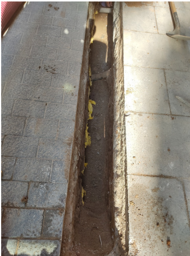
Foto 21: Rasa del carrer de Lancaster 7-15. Fons amb serveis d'electricitat.
