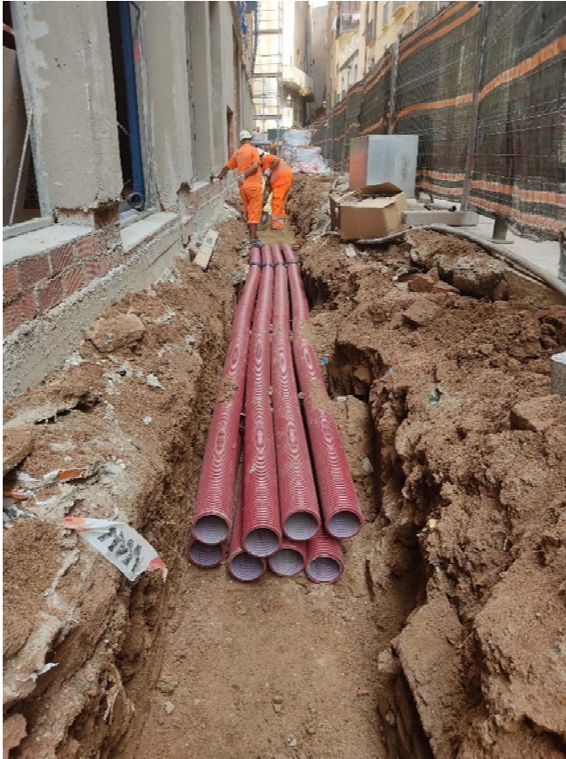
Foto 7: Cobriment de la rasa al carrer de l'Arc del Teatre.
