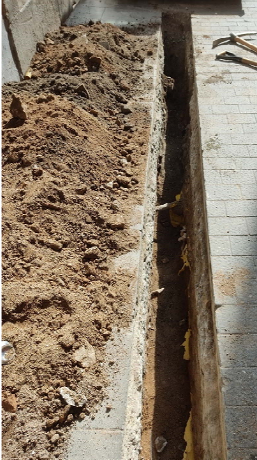
Foto 26: Rasa del carrer de Lancaster 7-15. Fons amb serveis d'electricitat.
