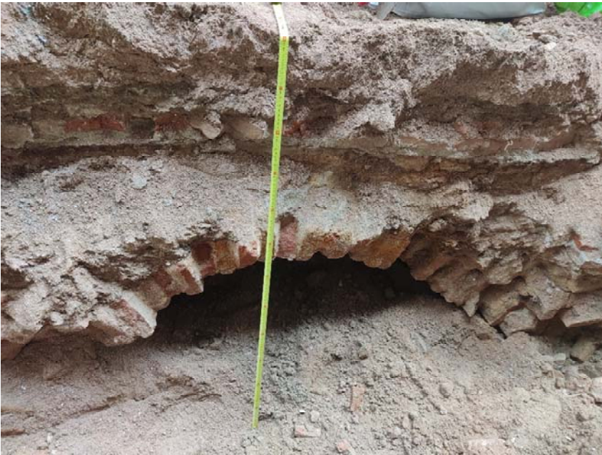
Foto 2: volta del col·lector del s. XIX-XX. La cinta mètrica marca 1,20 m de fons.
