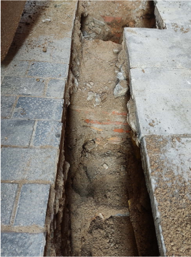
Foto 22: Serveis i basaments d'embornals contemporanis. Rasa del carrer de Lancaster 15-7.
