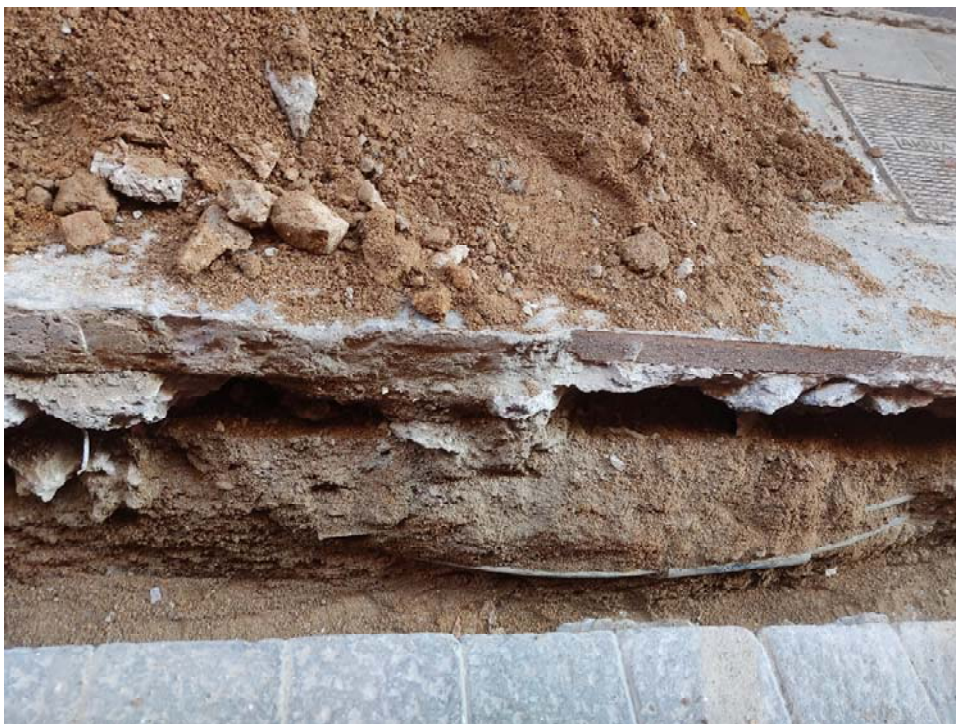
Foto 25: Rasa del carrer de Lancaster 7-15. Fons amb serveis d'electricitat.
