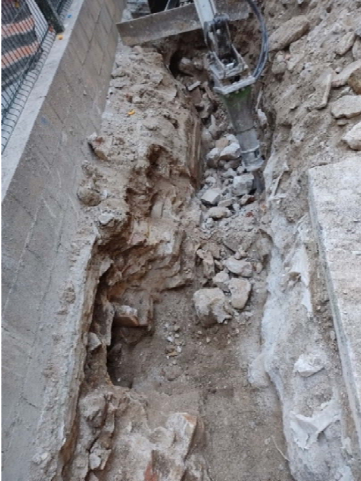
Foto 14: desmuntatge de les estructures muràries del edifici del s.XIX-XX a la placeta d'Anna Murià 1-2.
