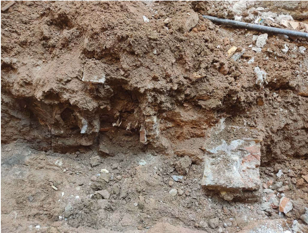
Foto 3: Mur UE 4 de maons lligats amb morter de calç. UE 4008 del informe del 2020.
