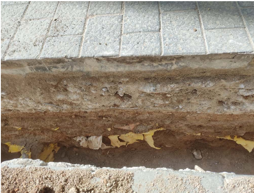
Foto 27: Rasa del carrer de Lancaster 7-15. Fons amb serveis d'electricitat.
